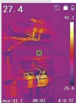
Repérez facilement et efficacement les mauvaises connexions ou les surchauffes dans une armoire électrique en détectant les points chauds.
