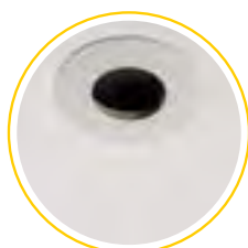
4. La bague de réduction est installée. L'ancien trou au plafond est bouché.
