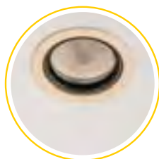
1. Ancien plafonnier encastré avec large découpe au plafond.
