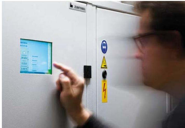
Central CPS pose de nouveaux jalons en matière de surveillance et de visualisation des systèmes d'éclairage de sécurité. Un PC tactile couleur WVGA de sept pouces, rétroéclairé par LED, au format 16 : 9, permet de visualiser l'ensemble de l'installation.
