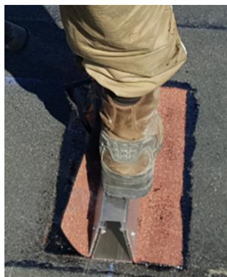
Soudure de la seconde bande de maintien
