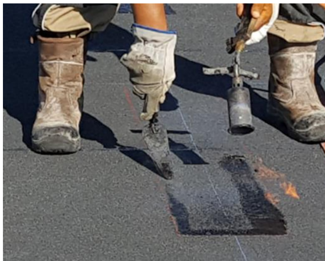
Soudure de la première bande de maintien
