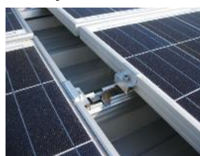
Au joint de dilatation
